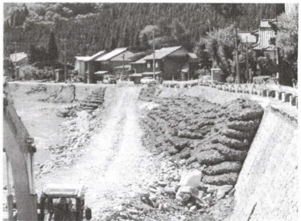
写真-7 路側仮応急工事（美山町折立地係）
