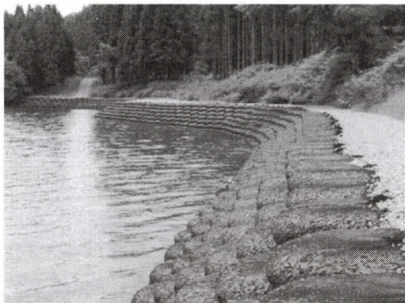
写真-12 袋詰砕石工法施工例 秋田県 田沢湖
