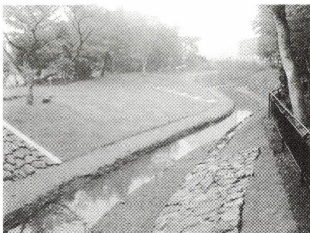
写真-20 ジオテキスタイル工法施工例 栃木県 御用川 施工後3ヶ月
