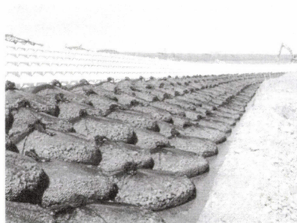
写真-14 袋詰砕石工法施工例 北海道 天塩川
