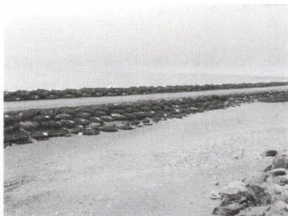
写真-16 袋詰砕石工法施工例 茨城県 旭築堤
