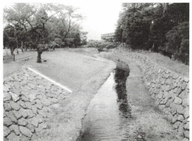
写真-21 ジオテキスタイル工法施工例 栃木県 御用川 施工後1年
