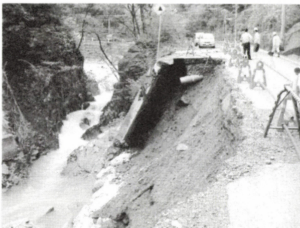
写真-5 路側仮応急工事（福井市上一光大丹生線）
