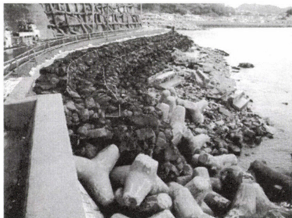
写真-13 袋詰砕石工法施工例 広島県 広似方停車場線海岸
