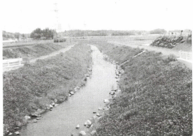
写真-11 平成 13 年度 小貝川災害復旧工事の例
