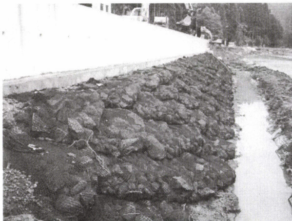
写真-8 仮設道路応急復旧工事 仮設道路構築に道路路盤、河川護岸 を兼て袋体を使用。
