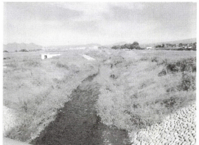
写真-19 ジオテキスタイル工法施工例 群馬県 寺沢川 施工後
