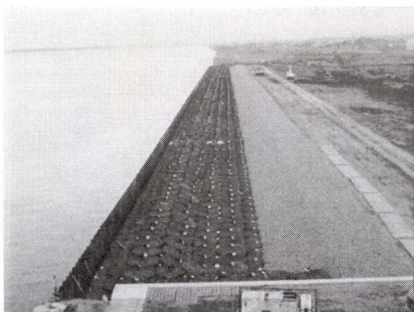
写真-15 袋詰砕石工法施工例 茨城県 利根川
