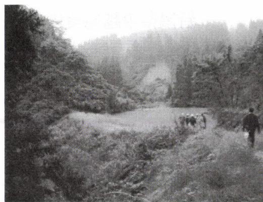
写真-1 びわ崎池天端の状況
