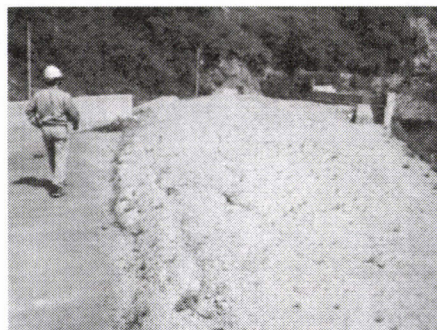
写真-4 補強盛土天端)
