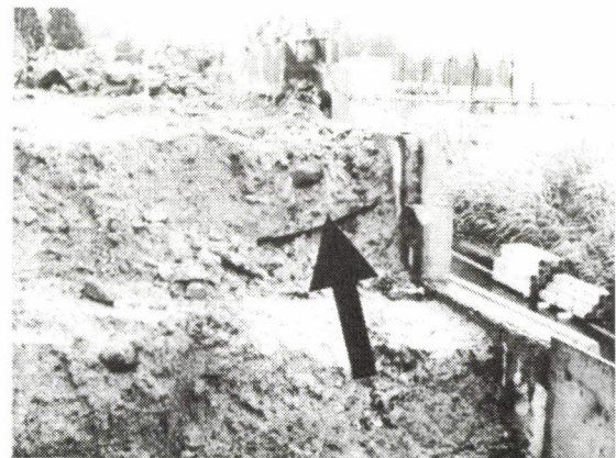
写真-6 擁壁 A のストリップの状態 (擁壁撤去時)
