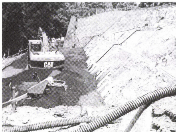
写真-14 堀削面に設置された不織布
