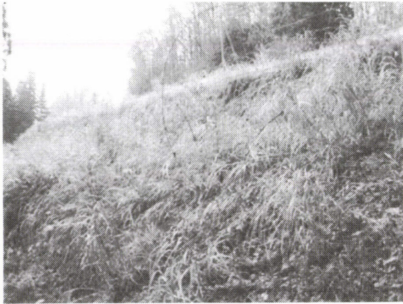
写真-1 補強土壁
