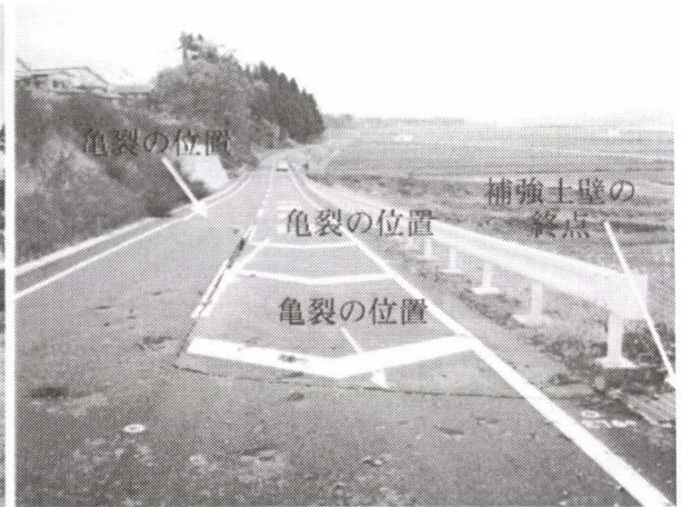
写真-4 道路アスファルト面の状況
