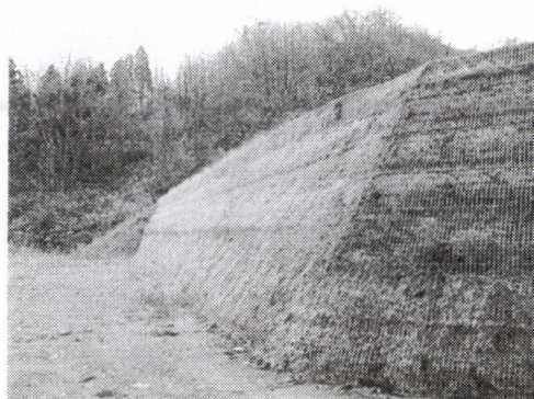
写真-9 壁面部の状況(FW 工法)・壁面部に変状なし。
