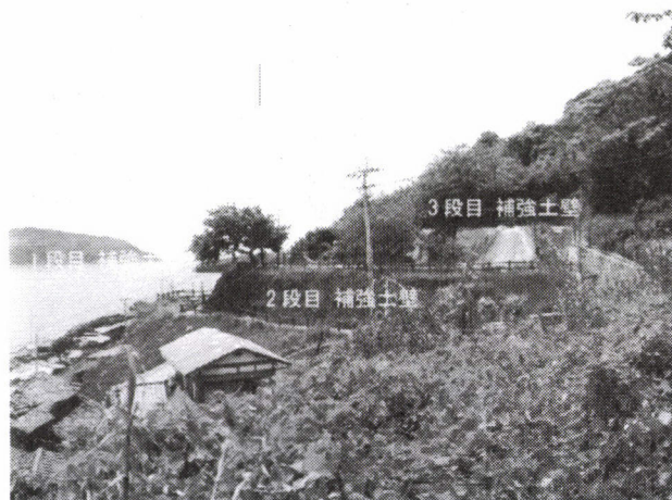
写真-1 玄界島公園の補強土壁(土のう巻込み)
