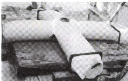
クロスジャケットにモルタルを注入したところ
