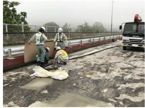
写真-4 中空床版橋のボイド管充填
