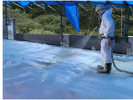
写真-2 拡幅盛土での施工
