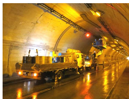
写真-1 片側車線規制での施工
