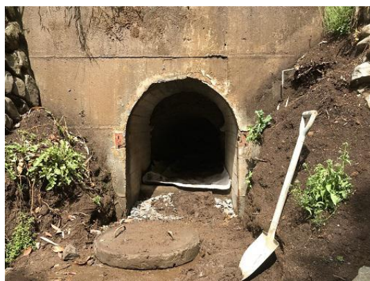
写真-7 充填施工前
