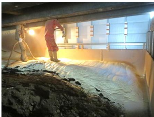
写真-5 桁下へのウレタン充填
