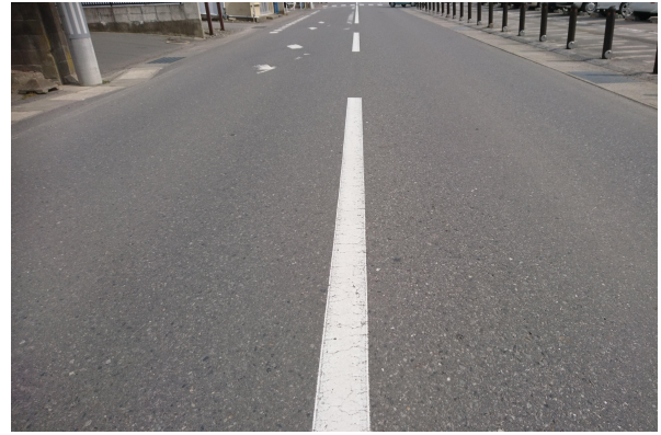
写真-6 施工10年後 (わだち・ひび割れ無し)
