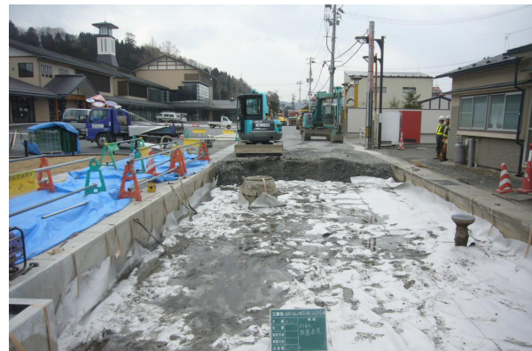
写真-4 ジオテキスタイル敷設後路盤材撤出し
