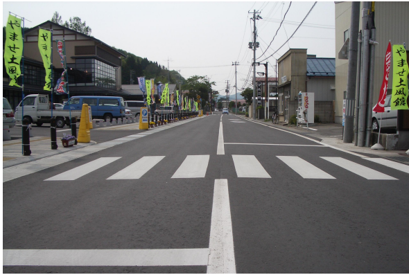
写真-5 施工直後
