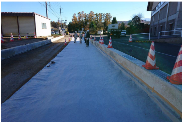
写真-2 ジオテキスタイルの敷設
