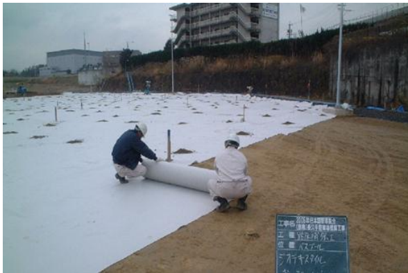
写真-7 施工状況
