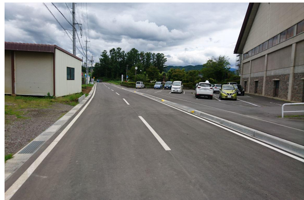
写真-3 AS舗装施工後
