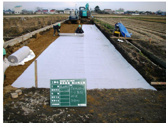
写真-1 ジオテキスタイル敷設
