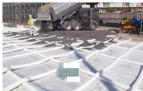
写真-4 パレスシートの施工例 (格子寸法 1m×2m)
