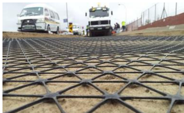
写真-1 テンサー TX 敷設状況
