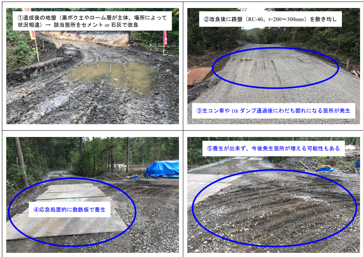
写真-2 軟弱地盤（改良済み）上の未舗装道路
