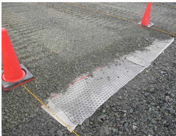
写真-4 ジオテキスタイル敷設状況
