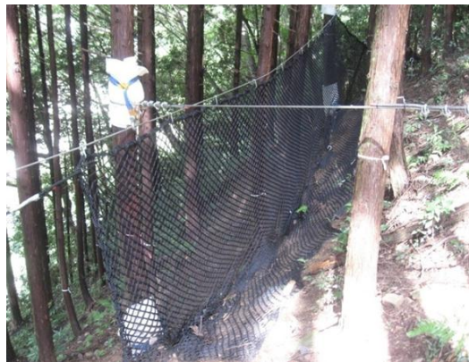
工事中安全対策
