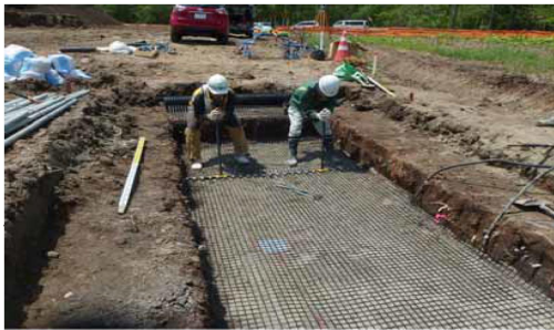
ジオグリッド敷設時の緊張状況 (ゆるみ除去)
