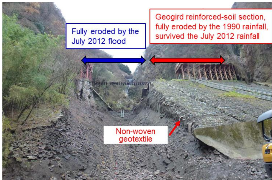
図-7 盛土再建後、再度の豪雨で流失した通常盛土と残った補強盛土 8)
