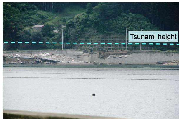
図-3 RSW1 補強土壁全容
