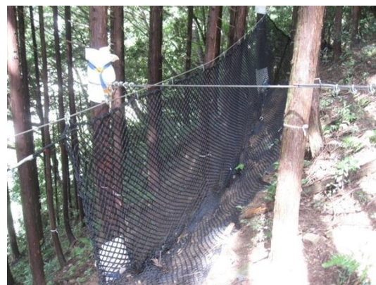
写真-14 工事中安全対策
