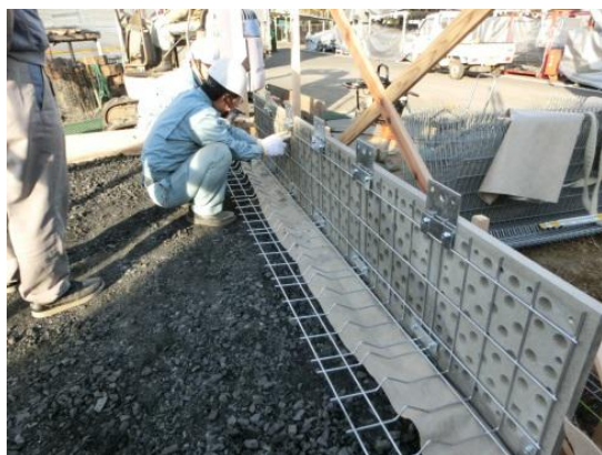
写真-11 壁面材の設置
