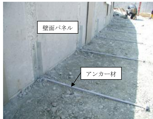
写真-6 壁面パネルアンカー材
