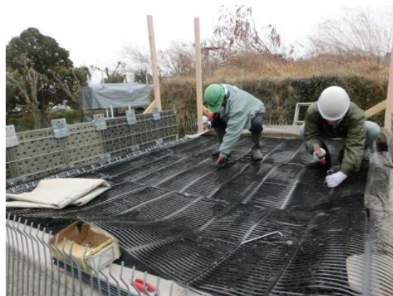
写真-12 補強材の敷設
