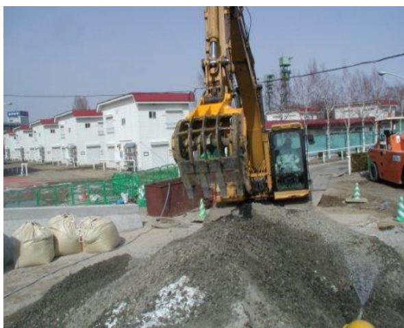
写真-5 改良土攪拌混合状況
