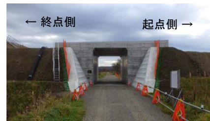
写真-5 B BOX 箇所全景
