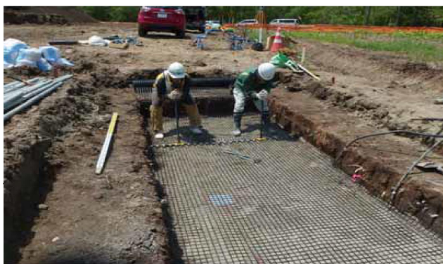
写真-3 ジオグリッド敷設時の緊張状況 (緩み除去)
