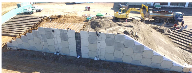
図-1 実物大試験補強土壁の全景
