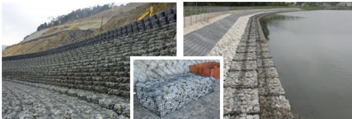
写真-2 スーパーかせんカゴ施工事例
