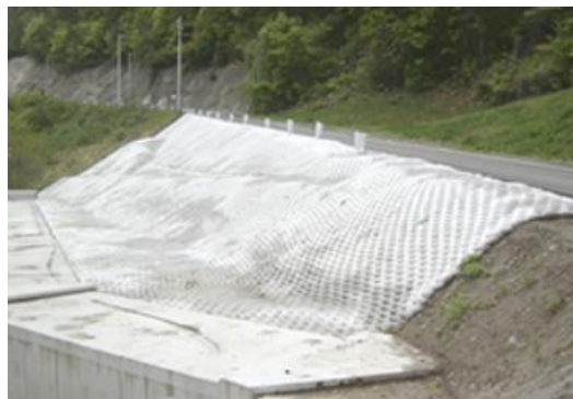
道路法面（長野県）
