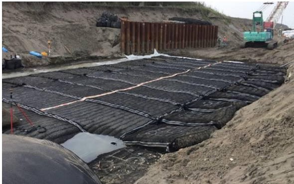
敷設後の全景
