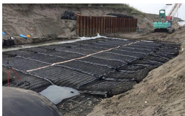
写真-12 敷設後の全景
