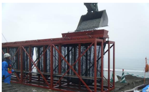
写真-10 セル型グラベルマットの中詰め作業
