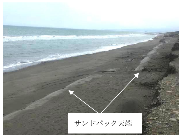
写真-15 約 4 年経過後のサンドパック天端
