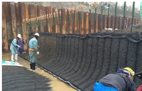
写真-11 セル型グラベルマットの敷設作業
