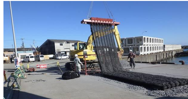
写真-4 中詰め材投入状況（陸上）
