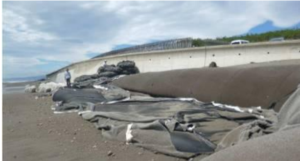
写真-7 サンドバックの変状 5)
