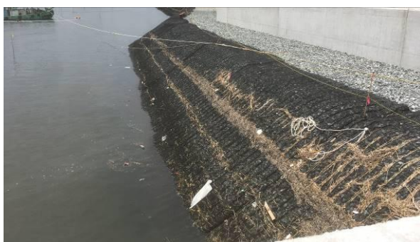
写真-18 据付完了後の状況
