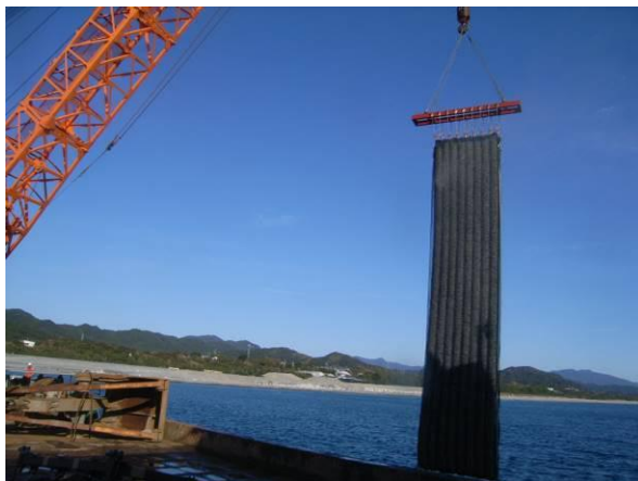
写真-5 敷設作業状況（水上）
