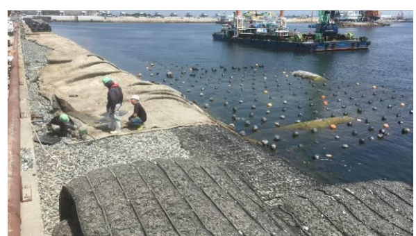
写真-19 遮水シート敷設状況
