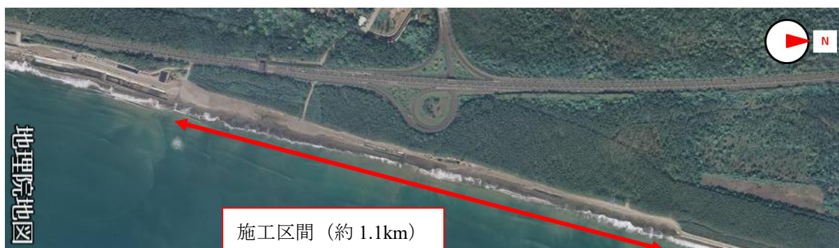
図-7 セル型グラベルマット施工区間 6)
