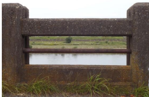
写真-5 「ダイヤレビーパネル」設置前
