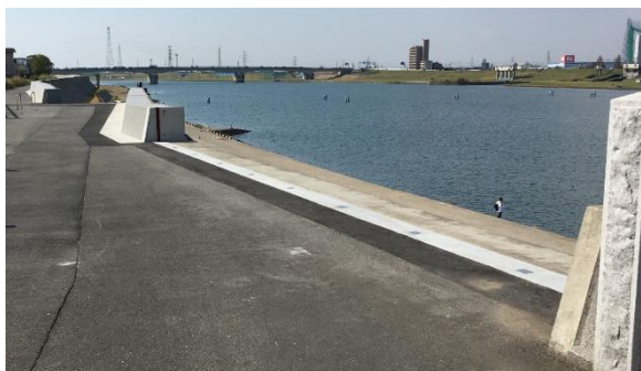
写真-9 止水パネル設置前
