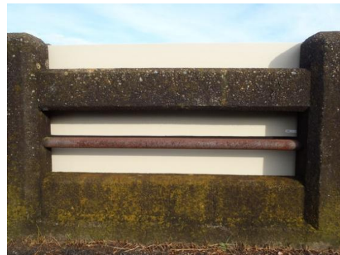
写真-6 「ダイヤレビーパネル」設置後
