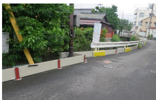
写真-12 止水パネル設置状況
