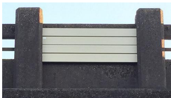
写真-1 支柱へのパネル設置状況
