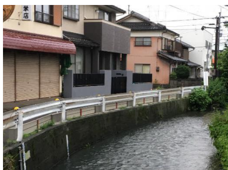
写真-11 止水パネル設置状況
