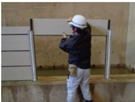
写真-7 止水パネルはめ込みの状況
