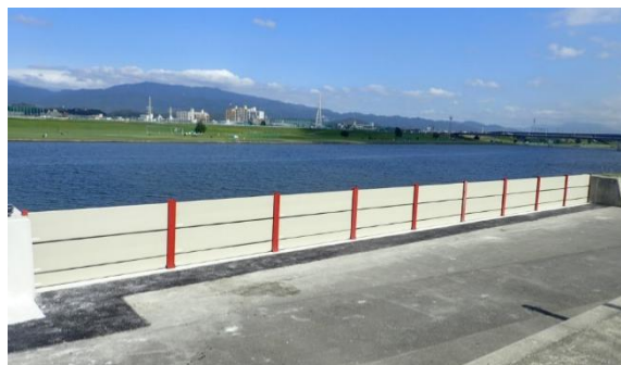
写真-10 止水パネル設置後
