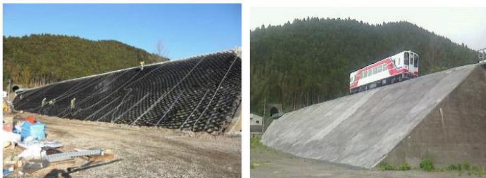
(a) 施工状況
