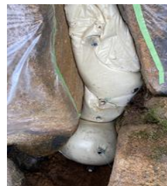
写真-5. 充填状況
