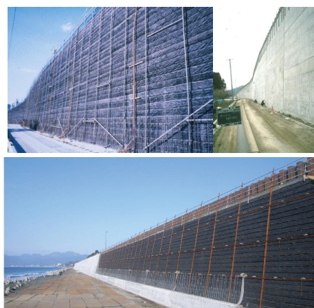
写真-1 RRR-GRS 擁壁の施工例 1), 2)
