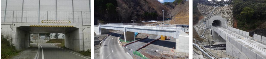
北海道新幹線架道橋 (RC) 三陸鉄道ハイペ沢橋梁 (SRC)九州新幹線厳守架道橋 (PCT 桁) (b) RRR-GRS 一体橋梁
