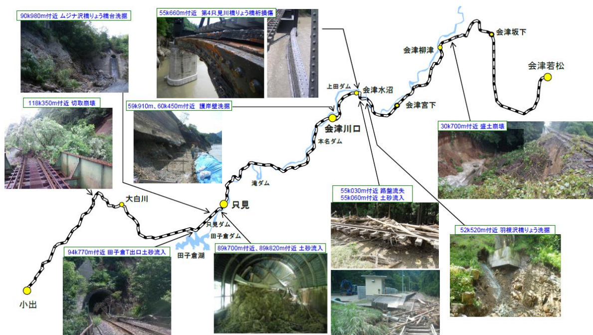
図-8 只見線における被害状況
