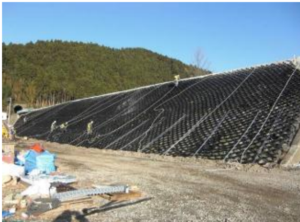
(a) 施工状況
