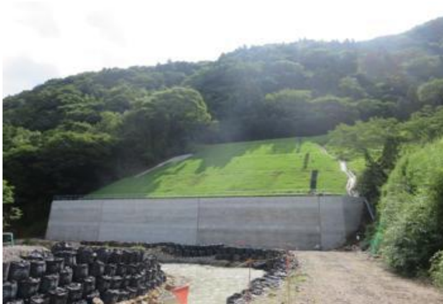
図-18 復旧盛土完成状況
