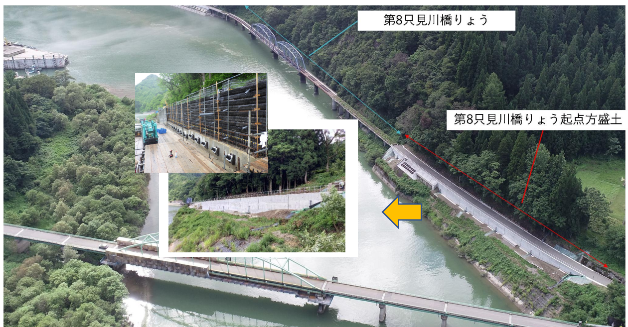
図-12 復旧工事の施工状況及び完成状況
