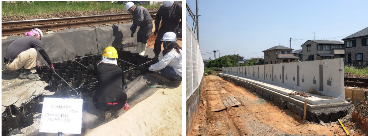
図-21 マットレスとしての適用（平成筑豊鉄道（田川線））
