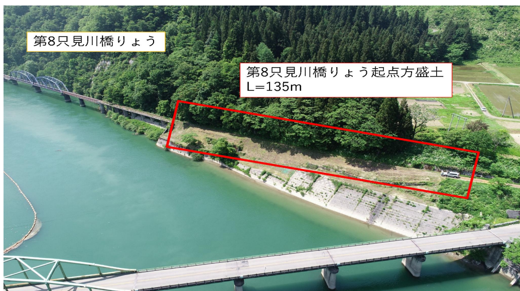
図-9 被災前の現場状況
