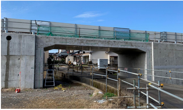
図-4 補強土一体橋梁（第1鬼橋架道橋）
