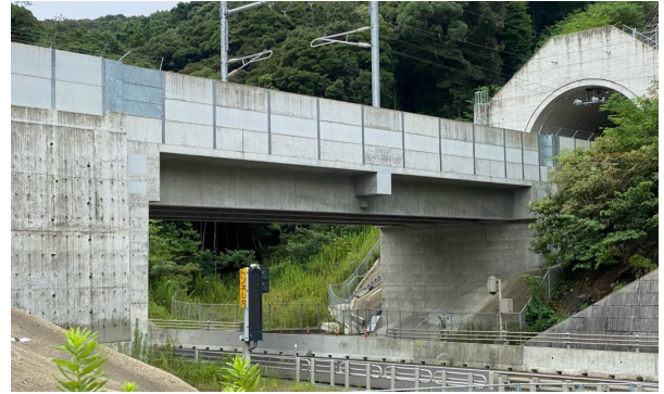
図-5 補強土一体橋梁（PC桁、原種架道橋）
