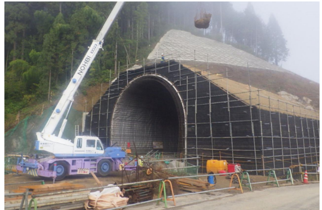
図-6 補強土トンネル坑門（第1鯖江トンネル）
