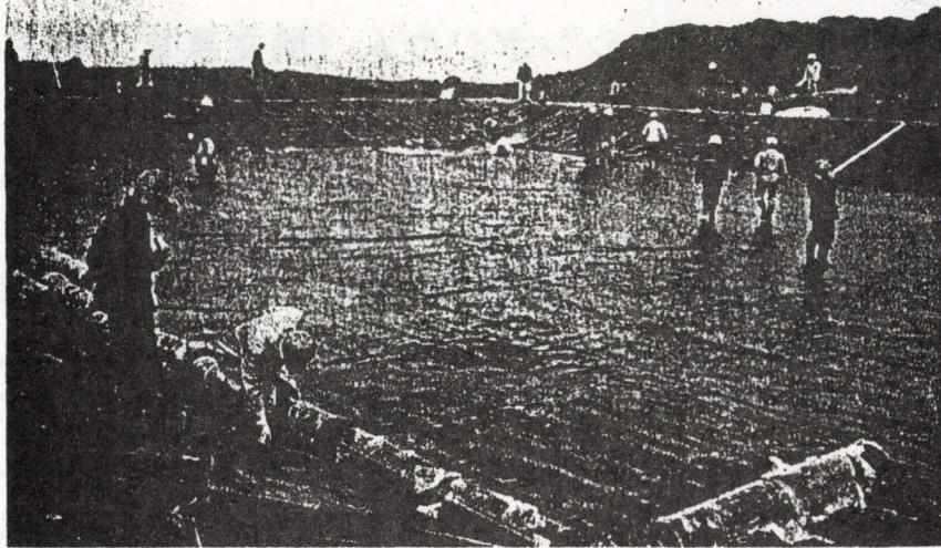
汚染廃棄物埋設場(青森)。掘削跡にジオメンブレンをダブルライナー(厚さ4mmのジオメンブレンを二重に敷き、その間に厚さ1mmの不織布を挟む)で布設したところ
