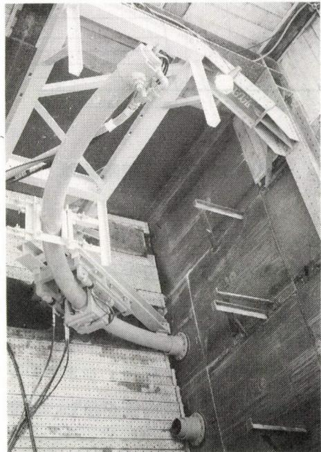
写真-5 立坑からの曲線ボーリング施工確認実験
