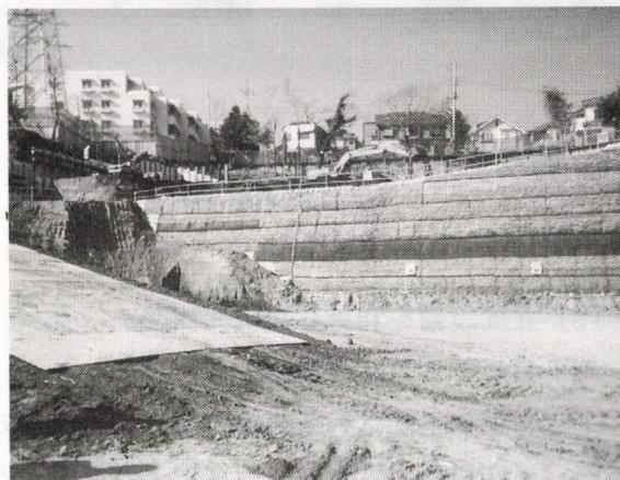
写真-6 工事用道路および完成後の駐車場としての盛土施工
