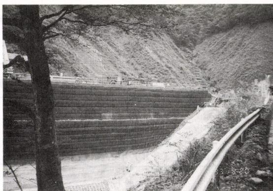
写真-7 トンネル工事の仮設ヤードとしての盛土施工
