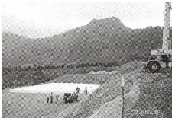
写真-1 一昨年、ハワイの州道路で施工されたEPS-Sジオフォーム(1993)
