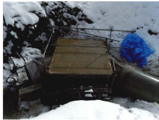
φ1200, 69 度曲管施工状況
