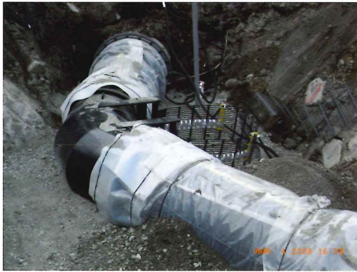
φ800, 56 度曲管施工状況
