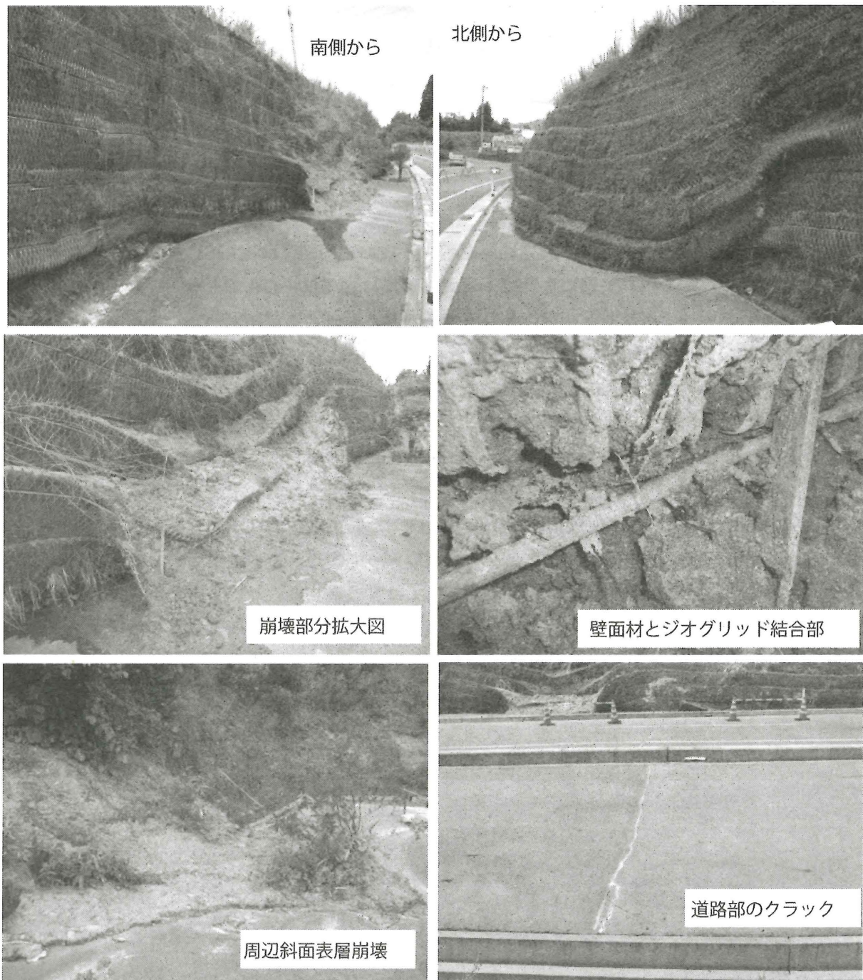
図-3 崩壊した補強土（岩手県奥州市水沢区）
