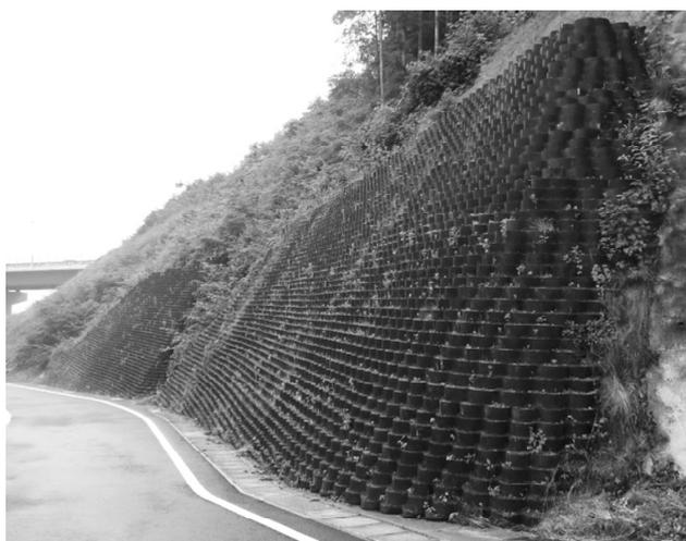
写真-2 テラセル擁壁 (切土のり面補強)
