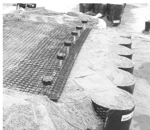
写真-4 壁面工と補強材との連結部
