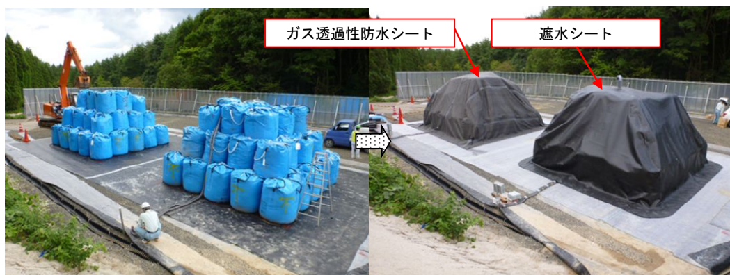
フレコン段積み状況(左)とカバーシート設置(右)
