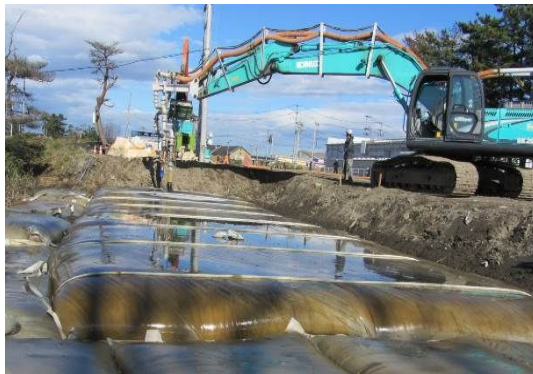
津波堆積土の処理状況
