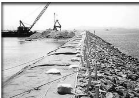
写真-1 吸い出し防止シート使用例
