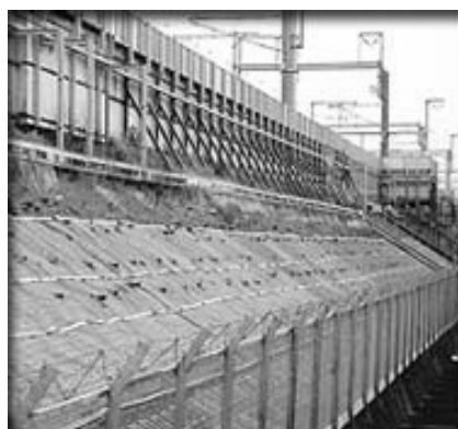
写真-3 防草シート使用例
