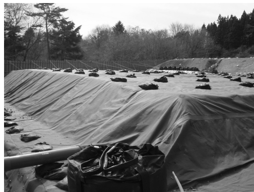
写真－５ 被覆シート使用例
