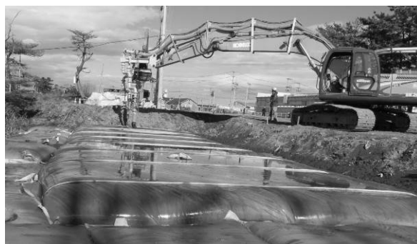
写真-9 定置型袋の施工状況
