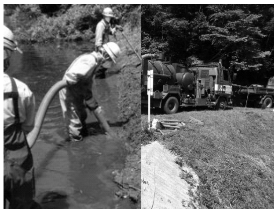
写真-10 集泥・吸引状況とバキューム車
