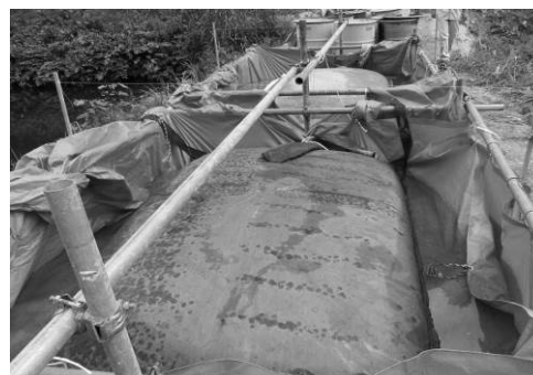
写真-12 脱水後状況 (28日後)
