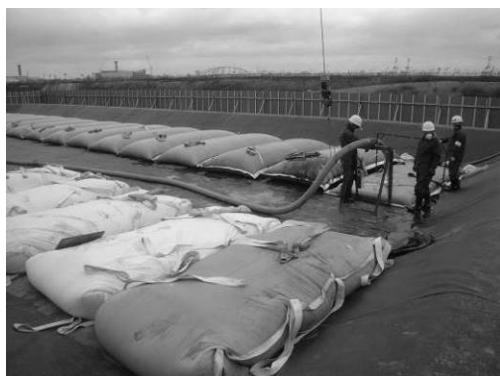
写真-4 充填状況
