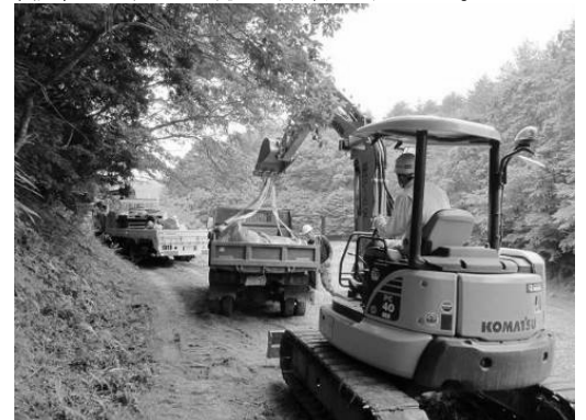
写真-13 脱水後の袋の吊り上げ・運搬状況
