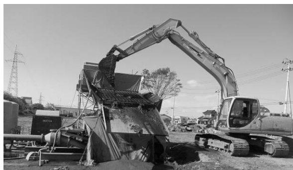
写真-8 泥土圧送機への投入状況
