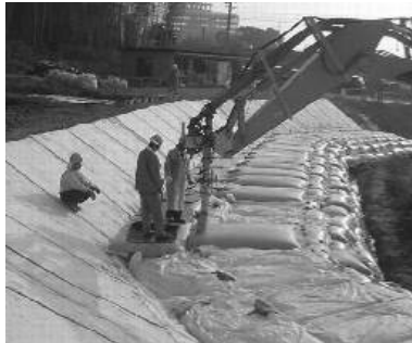
写真-2 充填状況
