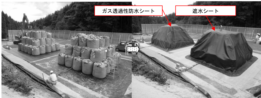
写真 - 2 フレコン段積み状況(左)とカバーシート設置(右)
