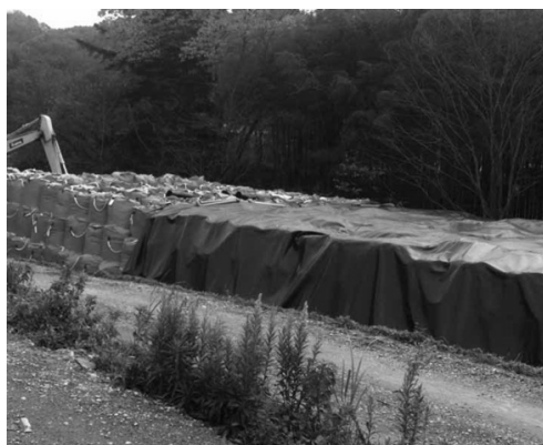
写真-1 仮置場状況
