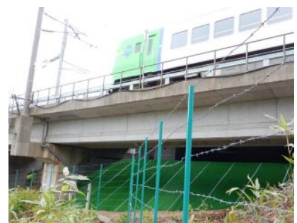
敷設後の状況
