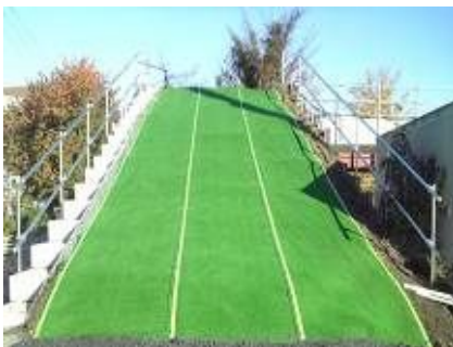
試験施工の状況
