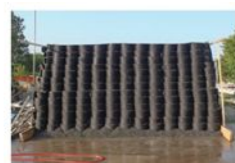
図-2 GIB 工法の出来形写真
