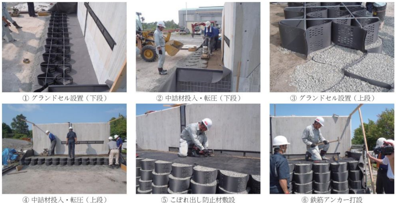
図-5 施工フロー
