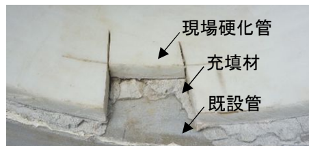
写真-3 エアミルクの充填状況
