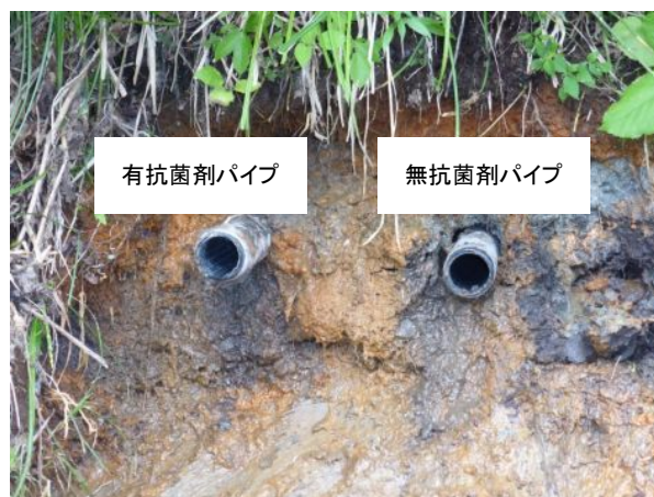
図-4 暗渠パイプ設置後の状況
