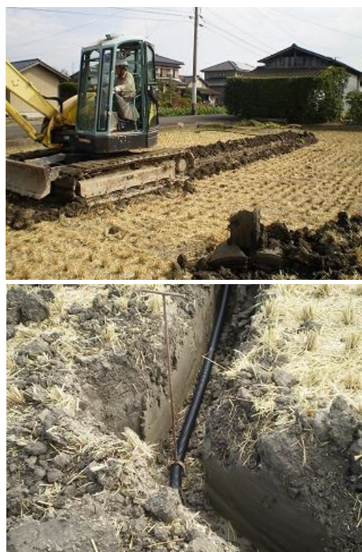
図-2 暗渠パイプによる圃場整備状況
