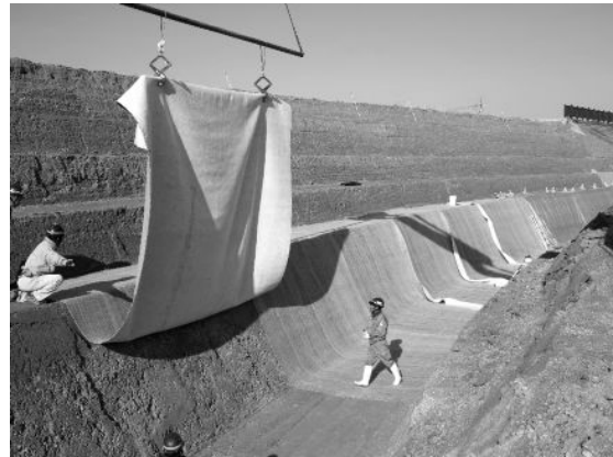
図-8 ベントナイトシート敷設状況
