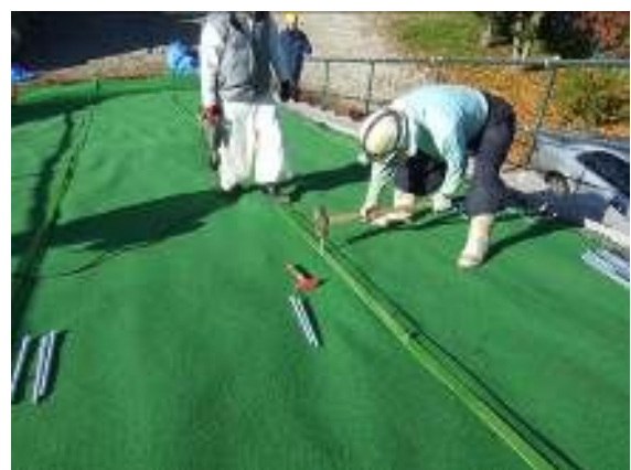
写真-5 固定杭打ち込み状況
