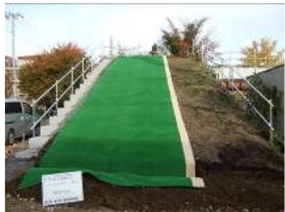
写真-3 敷設状況
