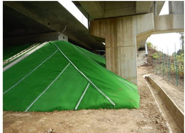
写真-11 敷設状況
