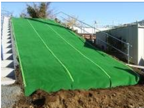
写真-6 のり尻部埋め込み状況
