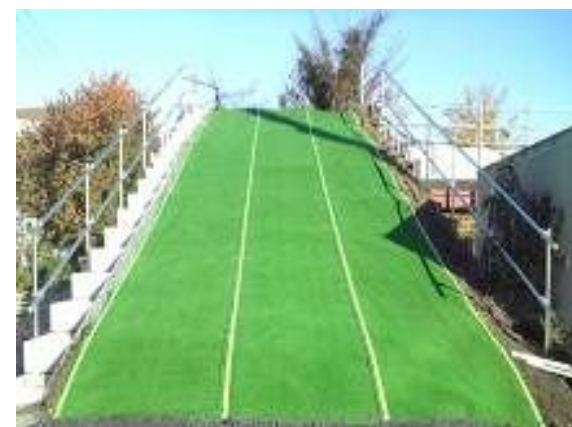
写真-7 敷設後の状況
