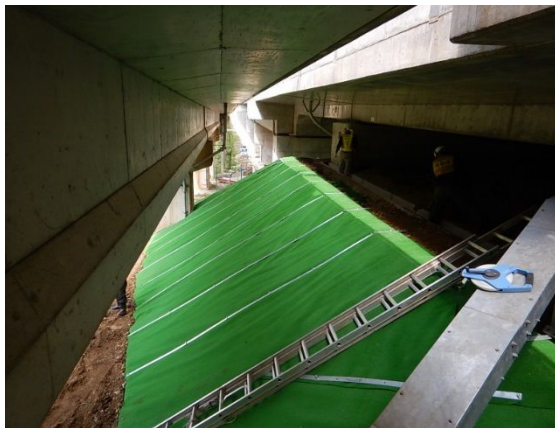
写真-12 敷設状況
