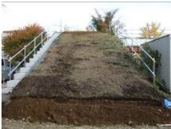
写真-2 敷設前の状況
