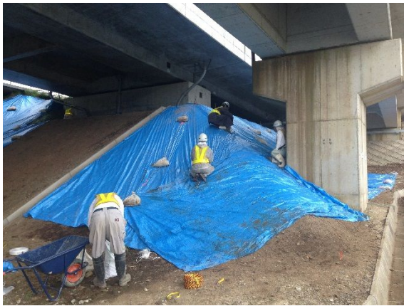
写真-10 敷設前の状況
