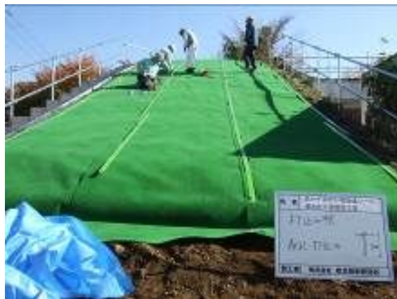
写真-4 平鋼取り付け状況
