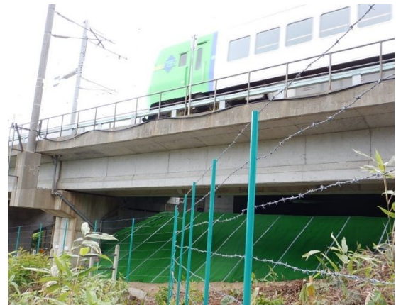
写真-13 敷設後の状況
