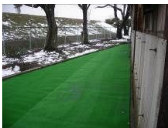
写真-9 敷設後の状況
