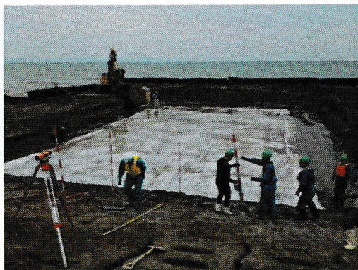
(a) 洗掘防止シートの敷設
