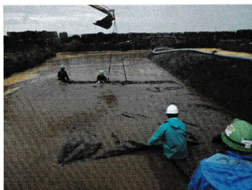
(c) アンカーチューブの充填作業
