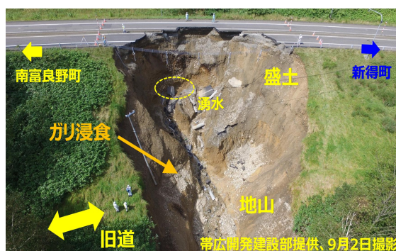
図-12 国道38号狩勝峠 盛土崩壊状況
