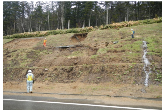
図-7 6 合目付近の切土崩壊状況
