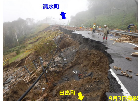
図-6 7 合目付近の盛土崩壊状況
