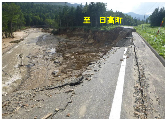
図-9 No.20 の盛土崩壊状況 3)
