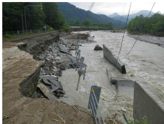
図-10 No.2 千坂擁壁の洗掘による崩壊状況 3)
