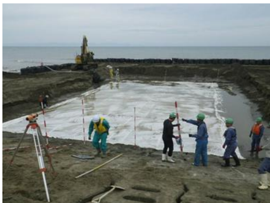
(a) 洗掘防止シートの敷設
