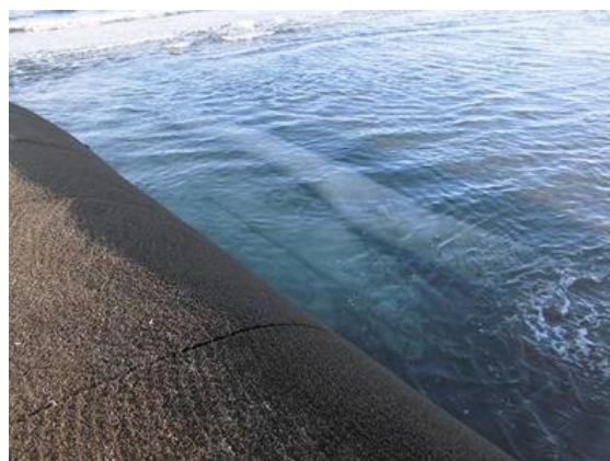
図-9 洗掘防止シートの状況
