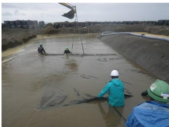
(c) アンカーチューブの充填作業
