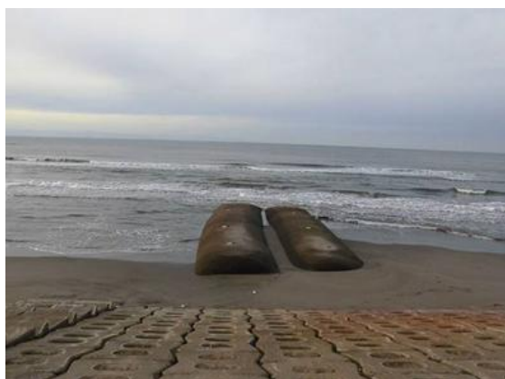
図-8 低気圧通過後の西側突堤
