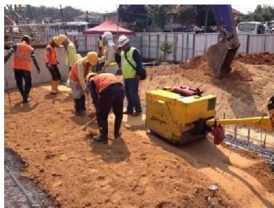
写真-5 小型転圧機使用状況
