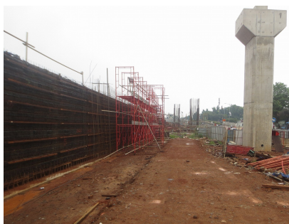
写真-7 補強盛土部完了①
