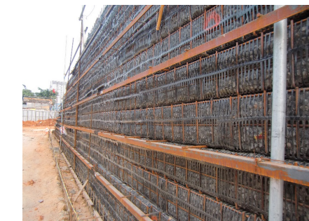
写真-8 補強盛土部完了②
