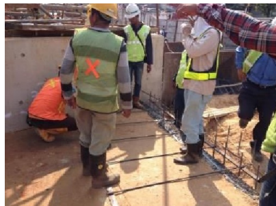
写真-6 型枠アンカー設置
