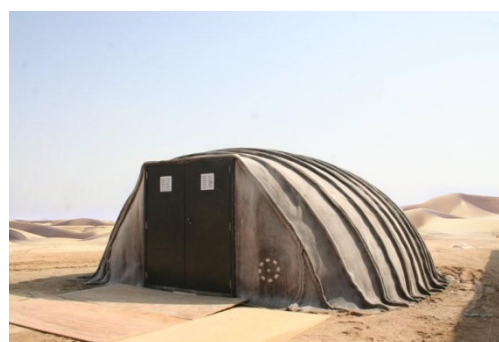
写真-1 膨張起立型シェルター構造
