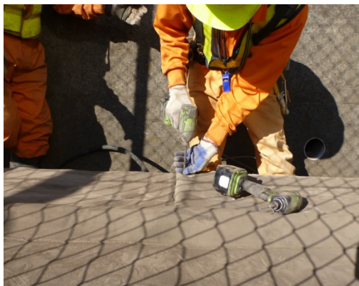
写真-4 継手部のビス止め作業
