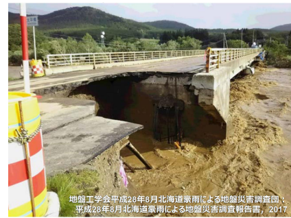
図-2 橋台背面盛土の被災事例
