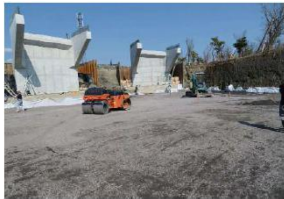
図-3 高知中央 IC (土佐国道事務所) の施工事例
