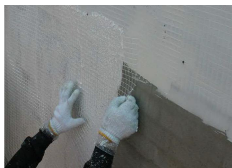
図-3 2軸ビニロンネット敷設状況
